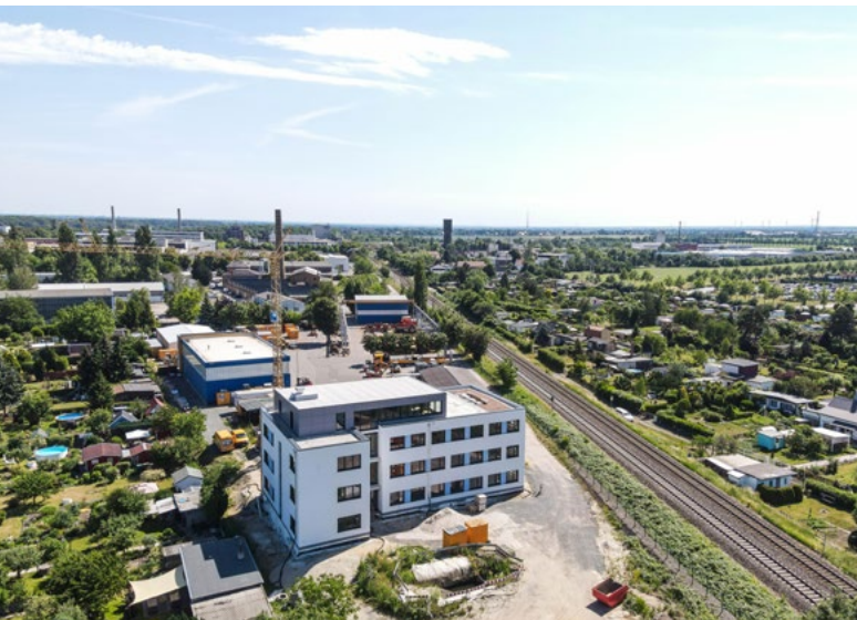
△ Baufortschritt des neuen Bürogebäudes, Leipzig
