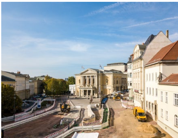
^ Baustelle im Jahr 2018 am Opernhaus „Bühnen Halle“
