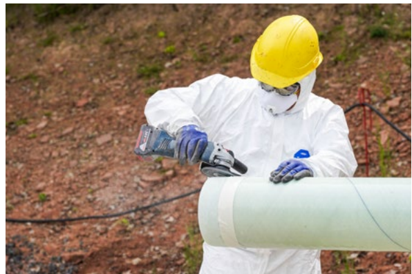
△ Vorbereitung von GFK-Leitungen, Philippsthal (Werra)
