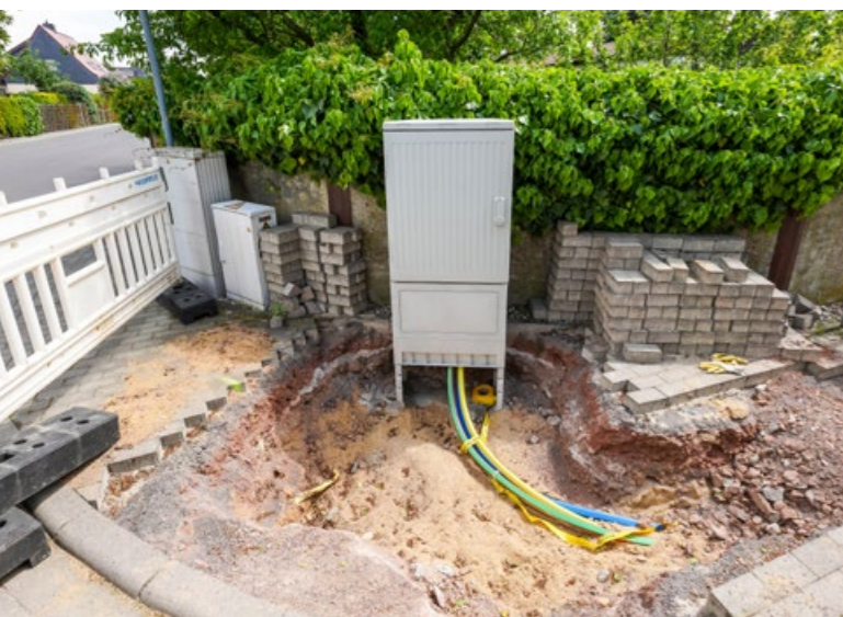
▲ Erster Netzverteiler in Grimma angeschlossen, Großprojekt Breitbandausbau, Siedlung Rumberg
