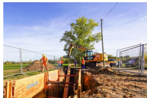
▲ Relining mit Langrohr, Leipzig-Miltitz
