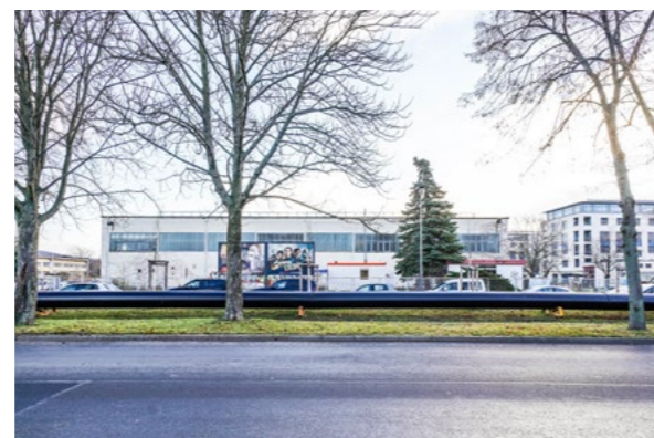
↳ Rohrstrang einer DynTec-Baustelle, Dresden-Striesen
