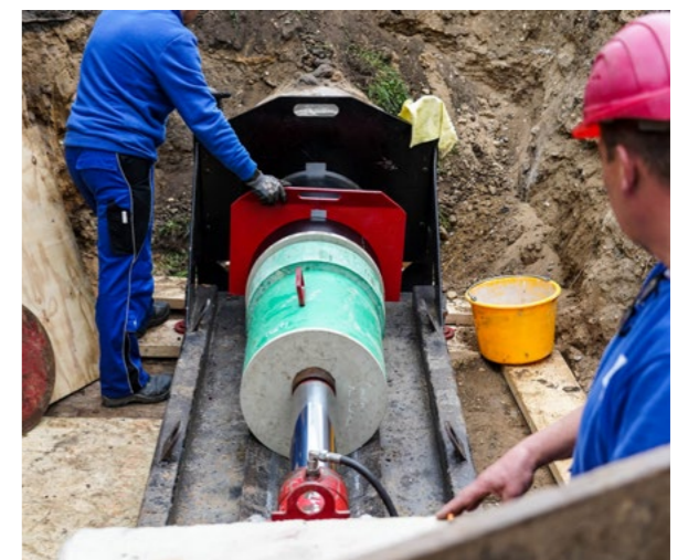
∨ Einbringen der Rohrmodule beim Kurzrohrrelining
