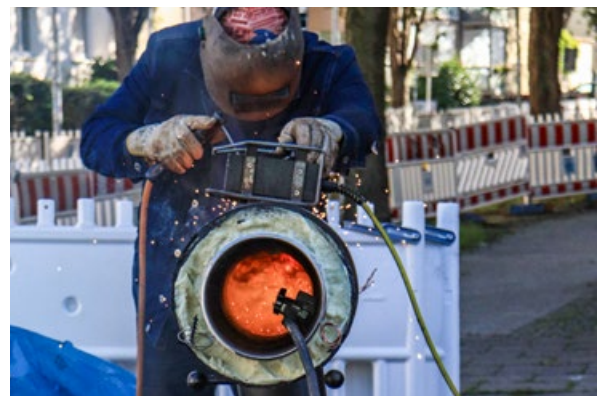
△ Setzen einer Schweißnaht am inneren Stahlrohr eines KMR-Rohres, Magdeburg
