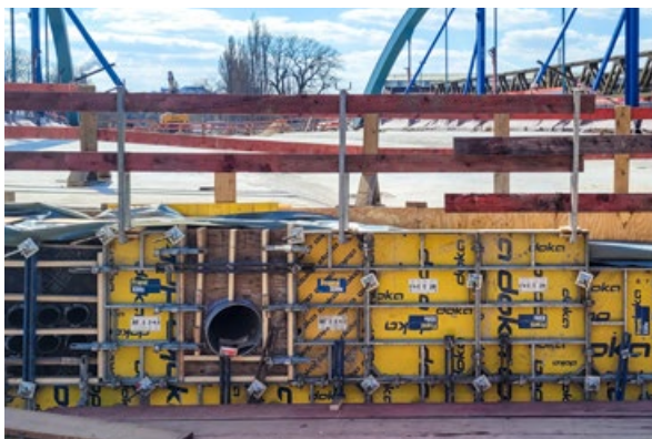
^ Unterkonstruktion der Brücke
