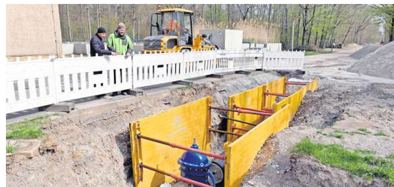
Anbindung der neuen Leitung an die alte, die ins Wasserwerk führt: Olaf Schröpfer (li.) und Michael Völkel schauen in die Baugrube.
